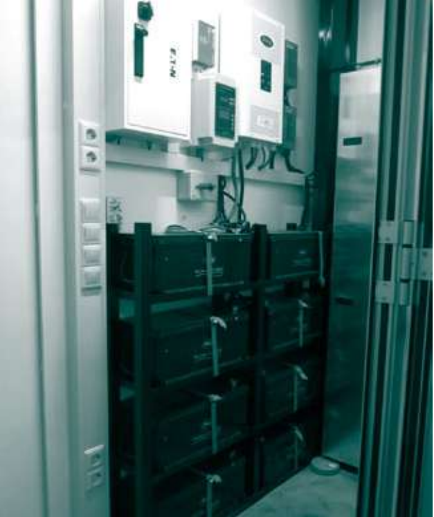
Ejemplo típico de un banco de baterías AGM alimentando a un inversor de 3,5 kW
